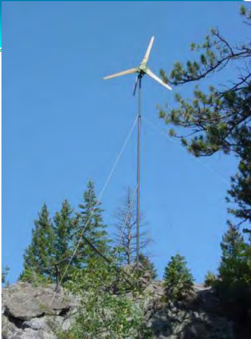
Konstruksi sistem turbin angin yang telah kokoh berdiri
